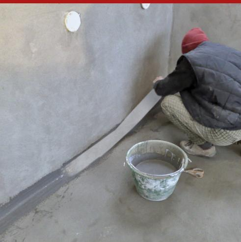
Fita para cobrir juntas, impermeável, constituída por uma borracha dilatável, de elastómero, inteiramente revestida em ambos os lados com tecido absorvente, com largura total de 12 cm. O produto se distingue pela simples e ágil aplicação, a correta impermeabilidade à água e a elevada capacidade de deformação.
