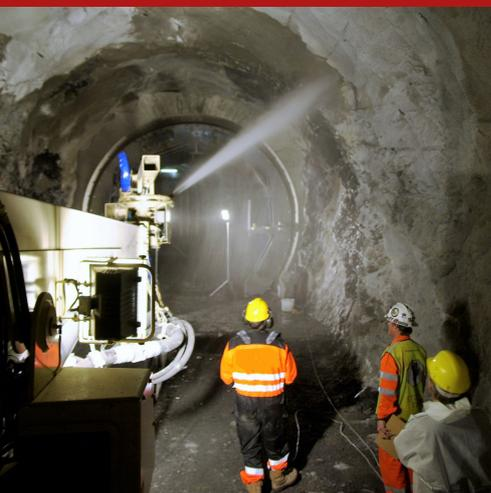
Solução de reativos minerais (silicatos de sódio) a utilizar para acelerar a presa de microbetões pulverizados e betões projetados na consolidação de rochas a céu aberto e/ou em túneis, na construção de revestimentos autossustentador e impermeabilizantes de túneis, canais, abóbodas, bacias, obras subterrâneas, etc., a utilizar com ferramentas específicas para misturas hidratadas (misturas nas quais o silicato é nebulizado no lançamento de saída do spritz-beton).
