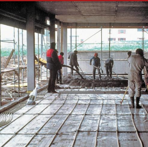
Aditivo polivalente em solução específico para a melhoria da condutibilidade térmica dos conglomerados cimentícios, através de equilibradas ações de tipo superlubrificante, desaerante, plastificante. Fluid Therm é perfeitamente compatível em combinação com fibras de aço Readymesh MM-150 (geralmente doseadas a 25 kg/m<sup>3</sup>) ou fibras de polipropileno multifilamento Readymesh PM-180 (geralmente doseadas a 1 kg/m<sup>3</sup>).
