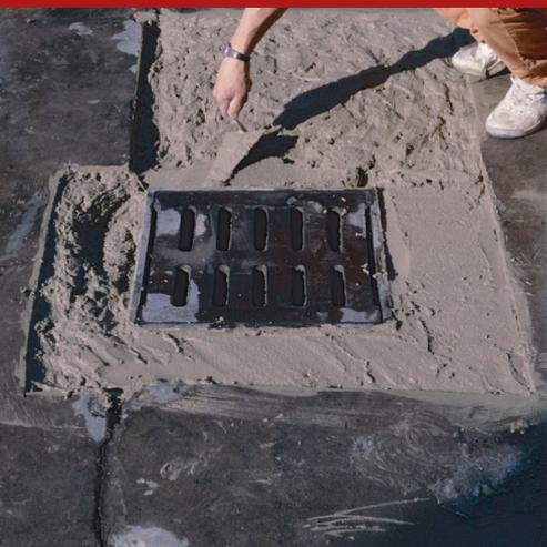
Argamassa fluida, fibro-reforçada com fibras de aço, com rápido endurecimento, a base de cimentos portland, ligantes especiais, agregados de sílica selecionados e agentes específicos de reologia, para reparações, reconstruções e ancoragens de rápido reuso, em obras diversas de betão, mesmo em condições climáticas severas e na presença de baixas temperaturas.
