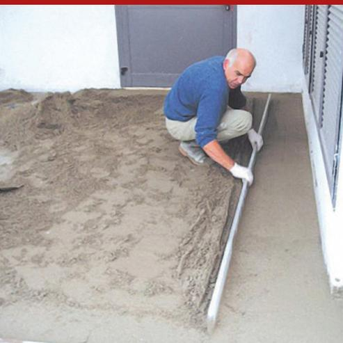
Conglomerado pré-misturado, compósito, fibro-reforçado, para a construção, com somente adição de água de amassadura, de betonilhas de pavimentação de espessura compreendida entre 40 e 60 mm, postos em operação com consistência de "terra húmida".
