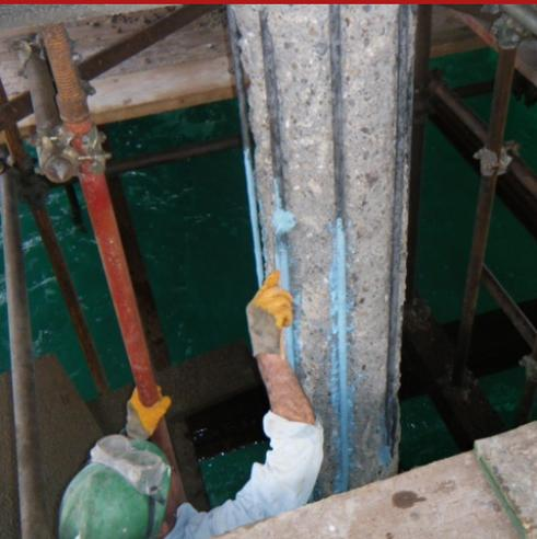
Pasta de cimento bicomponente, modificado com resinas de flexibilização e específicos agentes inibidores de corrosão para o tratamento passivante dos ferros de armadura oxidados, no restabelecimento de betão degradado.
