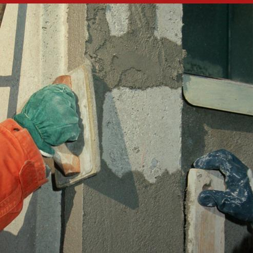
Argamassa cimentícia estrutural, de dois componentes, composta, com retração compensada, reforçada com fibra, à base de cimentos de alta resistência, cargas superpozolônicas, resinas poliméricas dispersas em água, inibidores de corrosão migratória, aditivos anti-retração, plastificantes, estabilizantes e anticorrosão agentes, agregados selecionados, microfibras READYMESH em vidro, com alto teor de zircônio, e polipropileno multifilamento.
