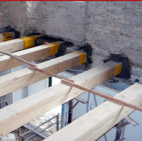
Argamassa tixotrópica, fibro-reforçada, antiencolhimento e levemente expansiva na fase plástica, com elevados desempenhos em termos de resistência características e impermeabilidade, específica para a compensação de cavidades e separações nos alicerces por chapisco e para fixação de precisão de travessas de madeira ou aço em paredes de qualquer natureza.
