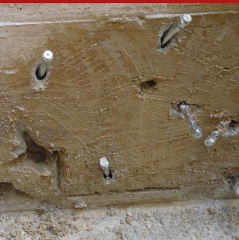
Injetor de borracha e aço para inserir em lesões, fissuras, fendas, juntas, cavidades, etc. a impermeabilizar com as resinas de poliuretano hidrófilas expansivas Syntech HAG Eco e Syntech HAG Flex, específicas para estancar imediatamente infiltrações de água. Dotado de "cabeça plana" com válvula anti-retorno, deve ser utilizado juntamente com o CONECTOR SYNTECH HAG. Disponível em dois tamanhos diferentes: Syntech HAG Iniettore 120 = 120x13 mm; Syntech HAG Iniettore 170 = 170x16 mm.
